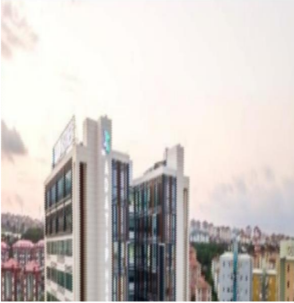
Elektrik ve mekanik tesisat işleri KURTKÖY ADATIP HASTANESİ
